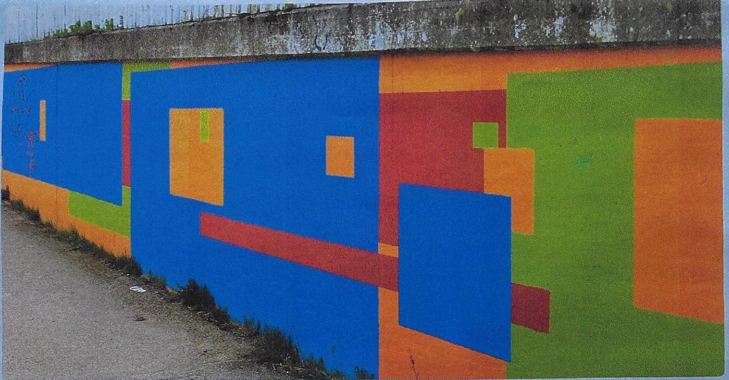
Figur 11: Klottersanering med färg.
